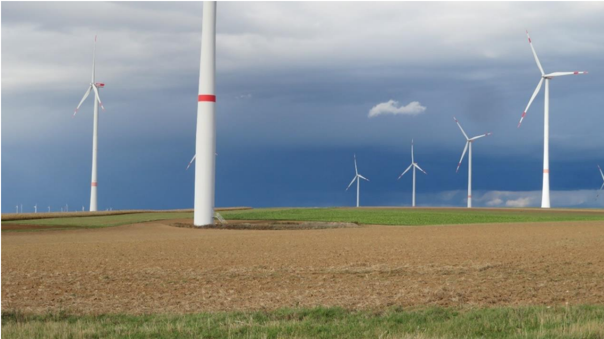
Bild 41: Windkraftwerke bei Biedesheim/Pfalz
