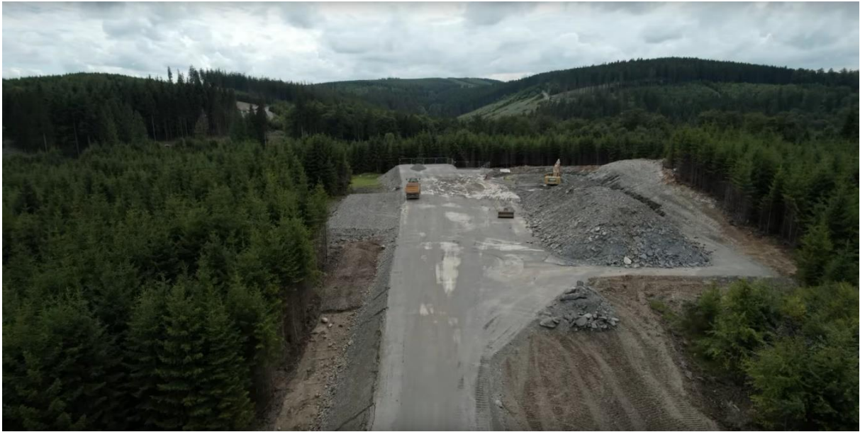
Bild 8: Geländeneivellierung für ein Windkraftwerk von 3,45 MW
