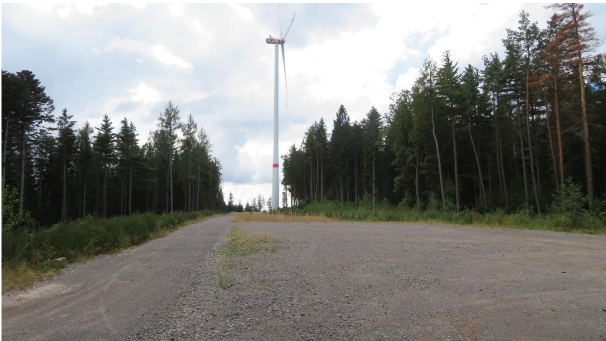
Bild 7: Dauerhaft gerodeter Wald für die Arbeitsfläche eines Windkraftwerkes auf dem Stillfüssel
